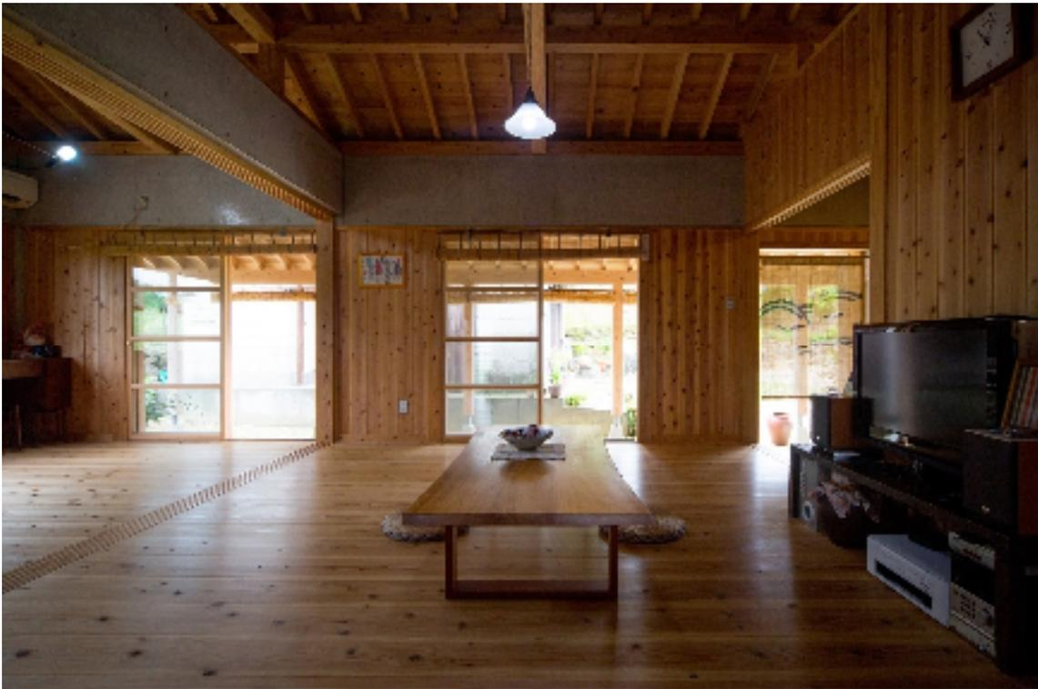
室内の様子 コンクリート梁の上に木の桁が架かっているのが分かる
