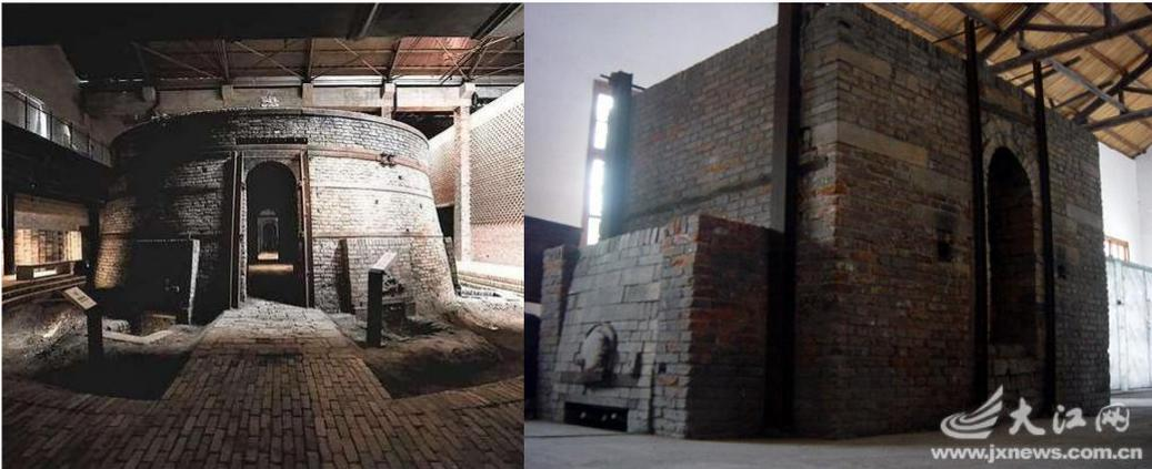
図 3.2 1950年代に景德鎮の国营工場が築いた角窯と丸形の倒焰式石炭窯
